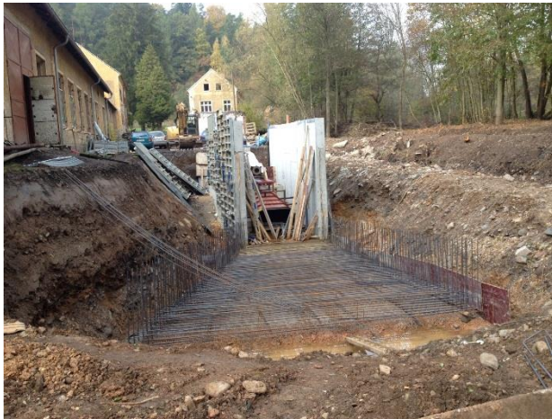
Výstavba odtokového kanálu
